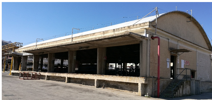
VISTA ESTERNA DEL CAPANNONE DI IMBOTTIGLIAMENTO
